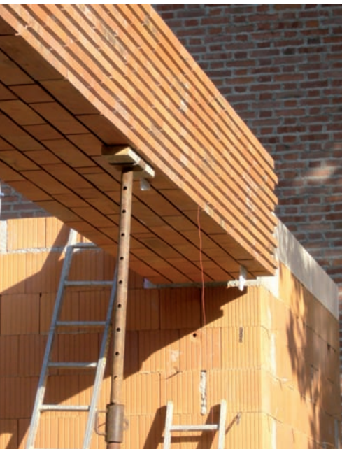
Thermische Trennung der tragenden Ziegelwand vom StB-Auflager des Fertigteilsturzes und der Klinkerhülle innen und außen, durch die Einfügung des Fensterrahmens als Trennelement
