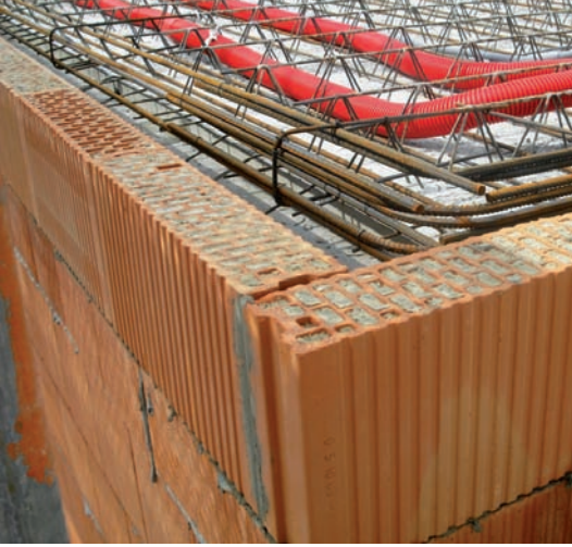
Deckenrandabmauerung 11,5cm
