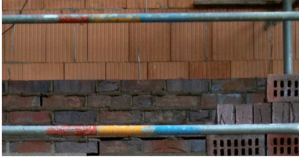
Anschluss Außenwand-Garage
