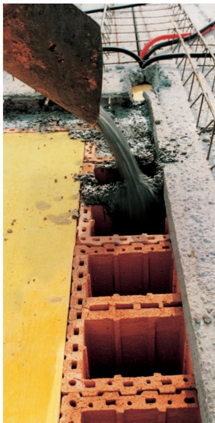
Die Verwendung von Ziegeln für Außen- und Innenwände verringert Verformungsunterschiede und reduziert somit die Gefahr von Rißbildungen im Mauerwerk.
