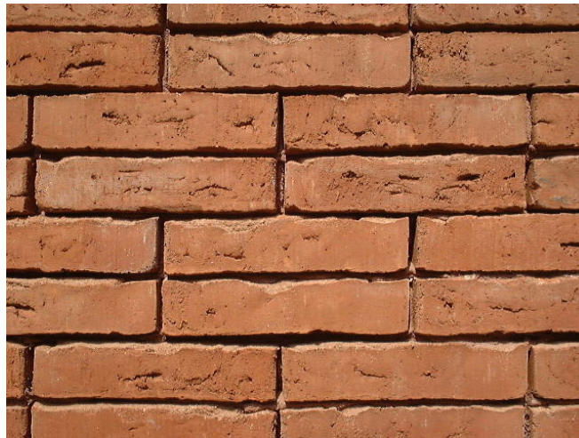
Bild 2: Geklebte Vormauerschale in Arnheim, Niederlande
