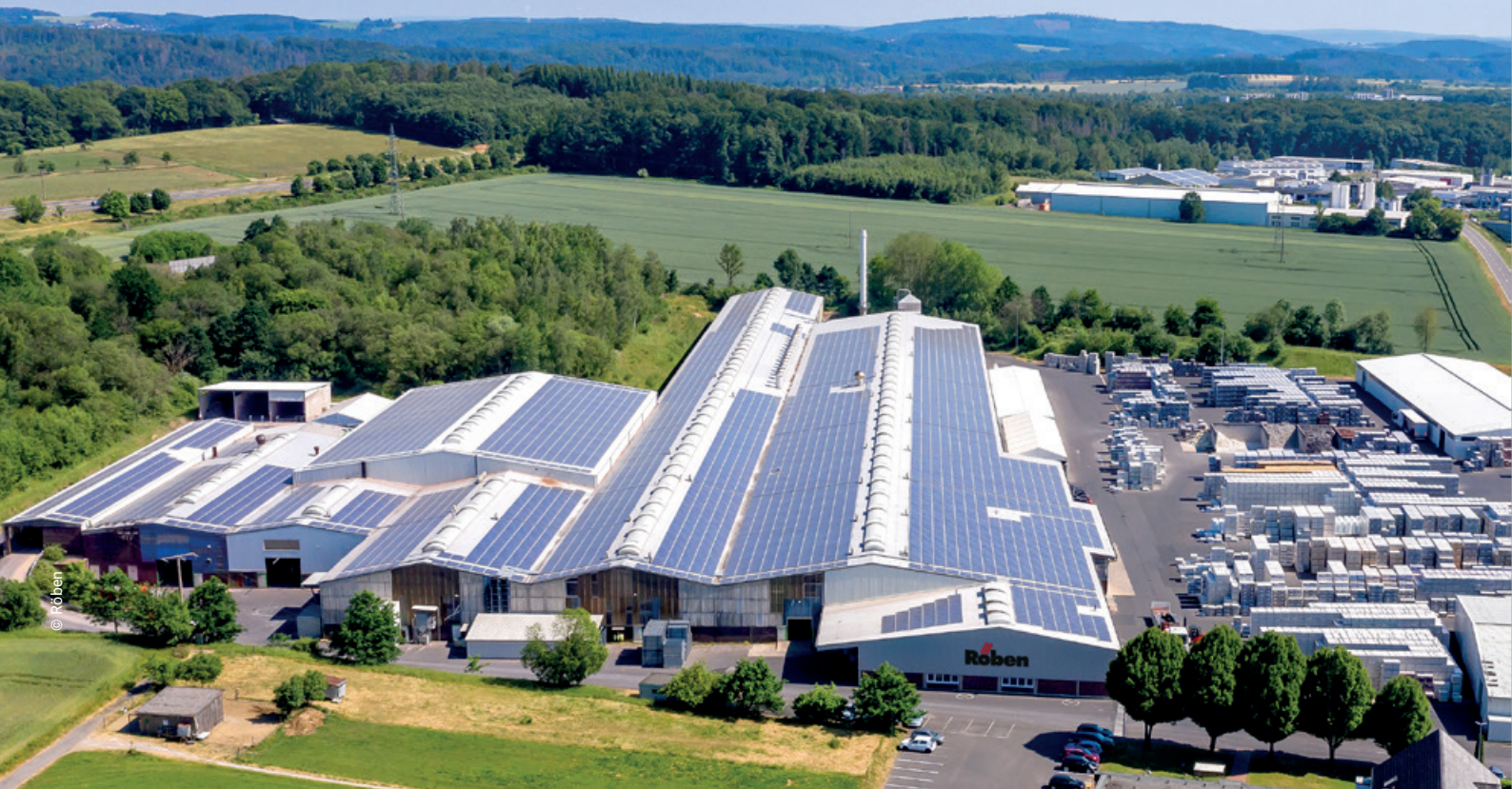
Solaranlage Werksgelände Röben | Röben
