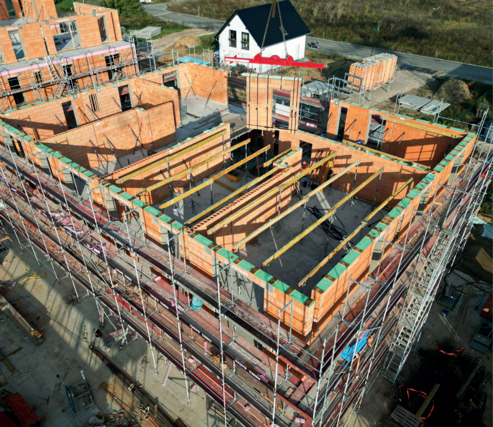
Anlieferung einer Ziegelmodulwand | © Schielecke Bau, Leipfing Bader
