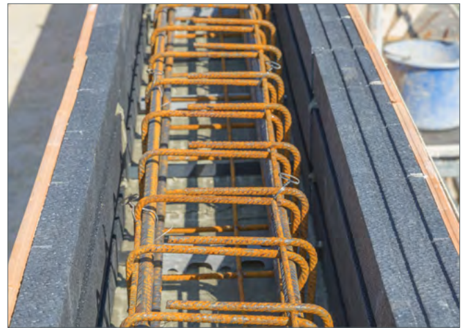
Abbildung 4.10: Zwei gedämmte Deckenrandschalen als Schalung für Ringbalken auf der Giebelwand
