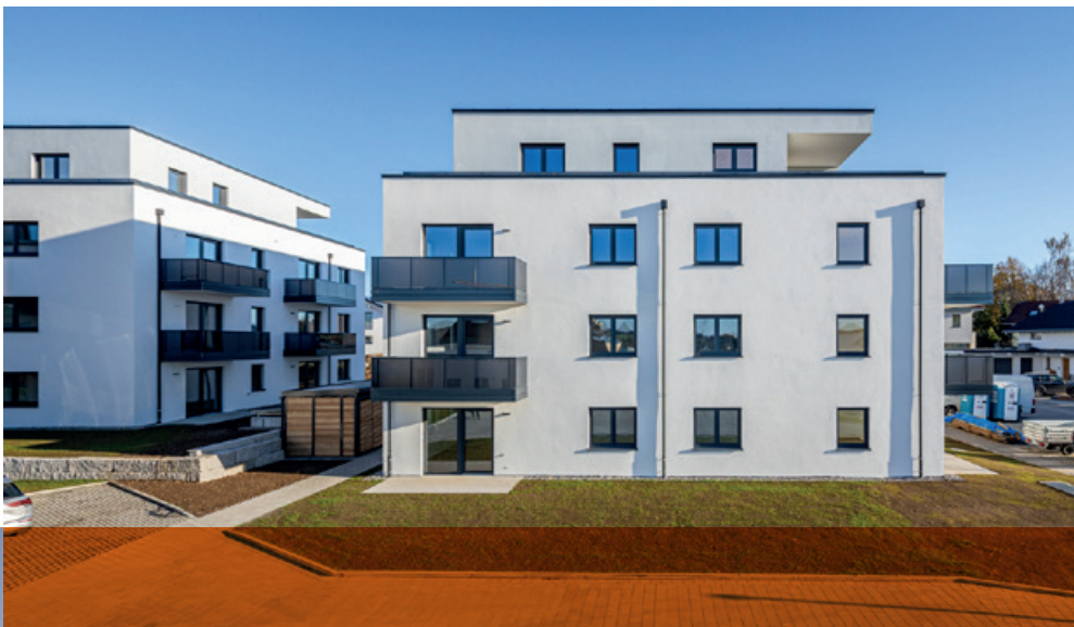
Neubau, Kißlegg, Leipfinger Bader | © Rehaar GmbH
