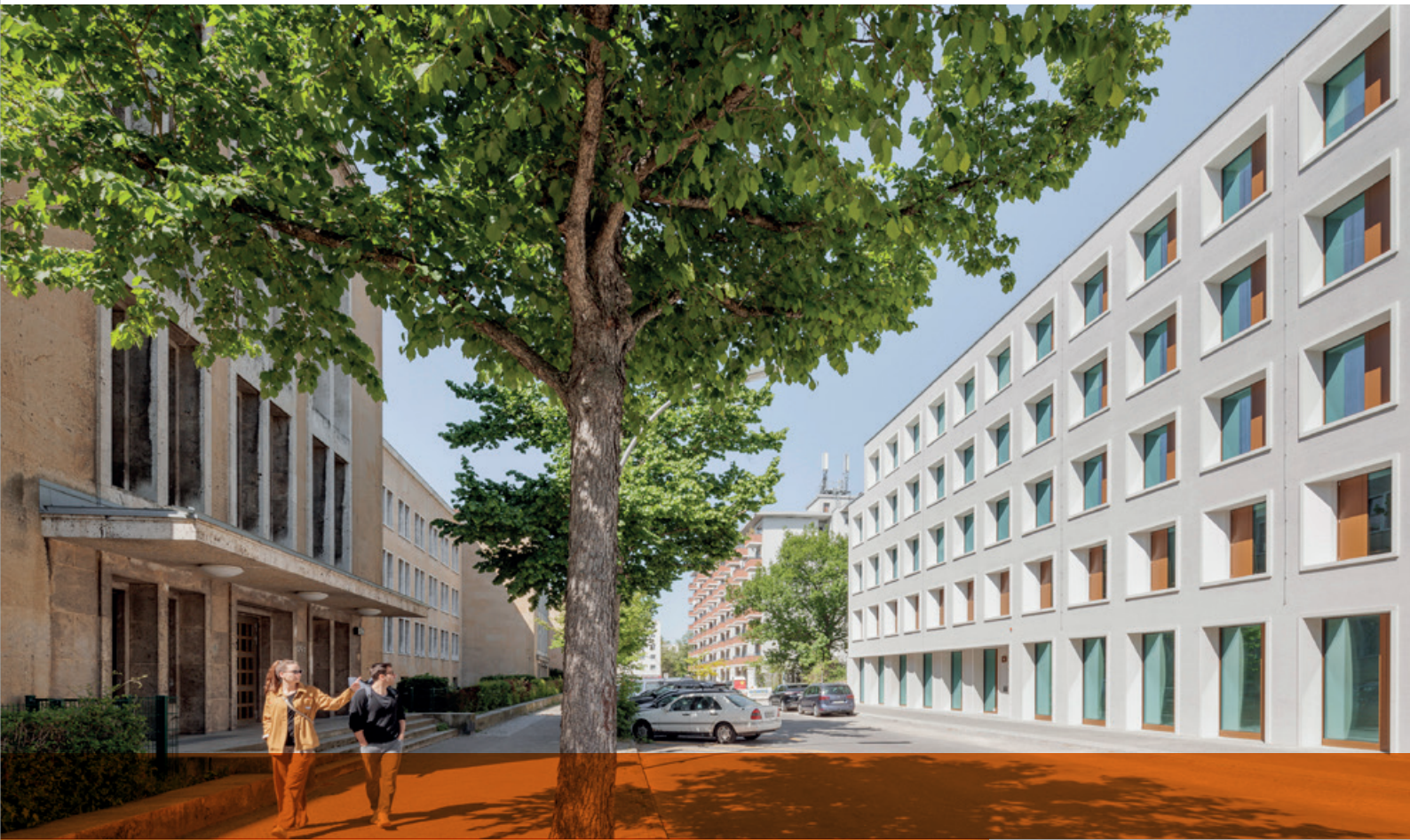
Monolithische Bauweise Verwaltungsneubau Unionhilfswerk in Berlin, Neubau | Baumschlager Eberle Architekten, Berlin | © Ulrich Schwarz, Berlin
