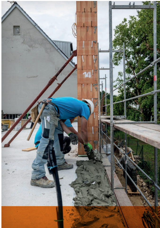
Fertigteile setzen | © Leipfinger-Bader
