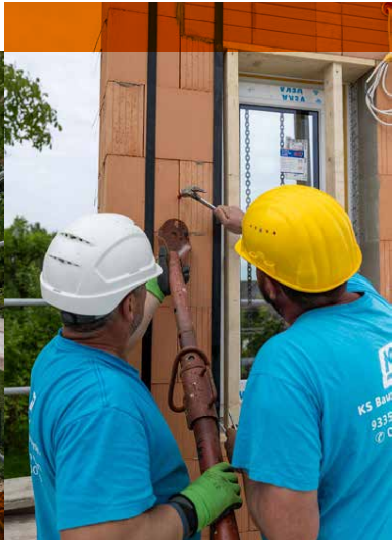
Bauweise mit Fertigteilen | © Leipfinger-Bader
