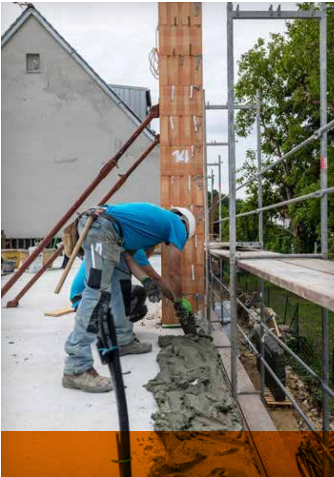
Fertigteile setzen | © Leipfinger-Bader
