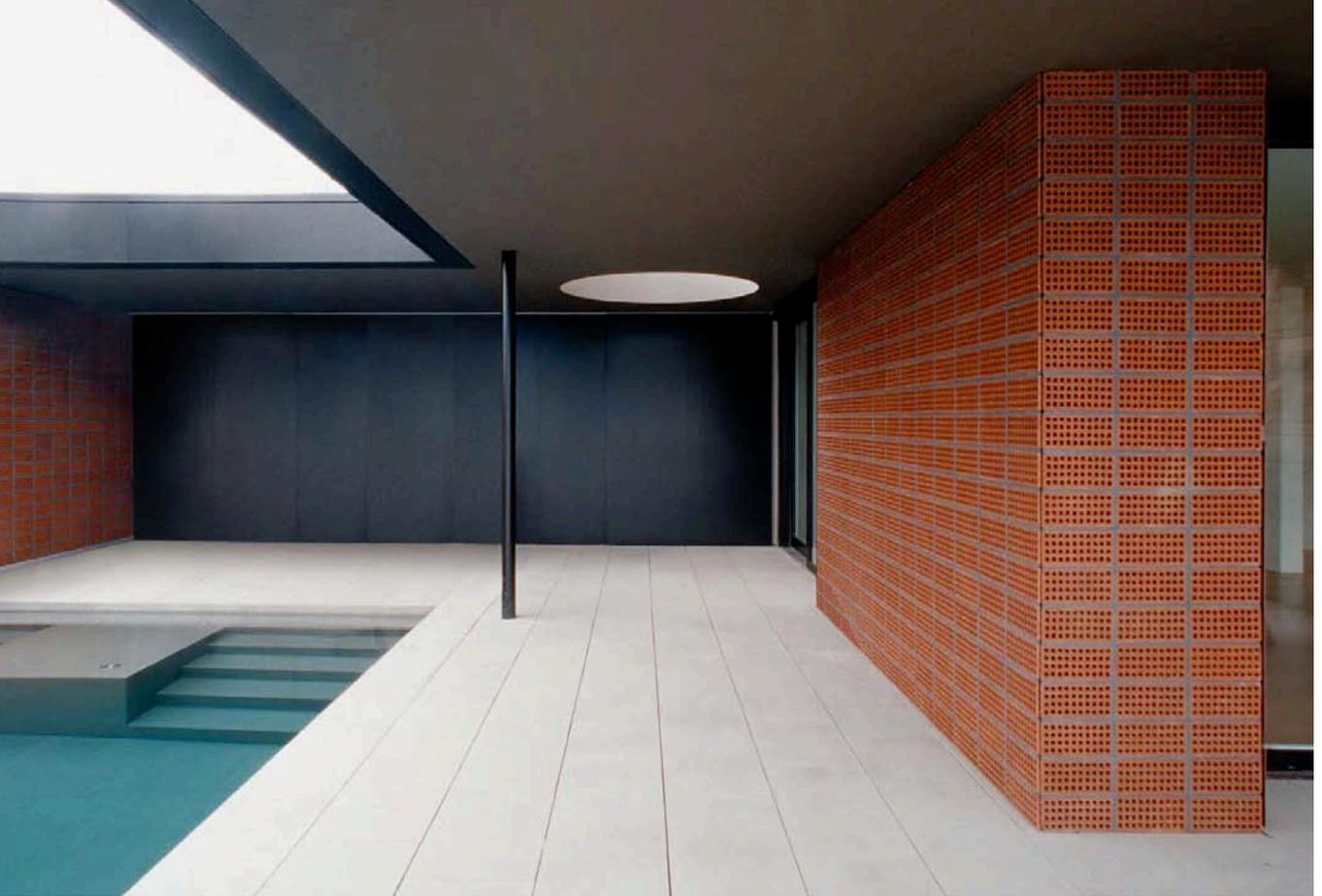
Auf der Suche nach einem Verkleidungsmaterial für die Fassade werden die Architekten bei einem ungewohnten, aber eigentlich sehr profanen Material fündig: Auf ihren Längsseiten liegende, im Kreuzverband gemauerte Backsteine, wie sie gewöhnlich für Schallschutzwände vermauert werden,
